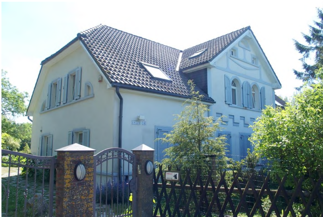
Widok budynku od północnego - zachodu
