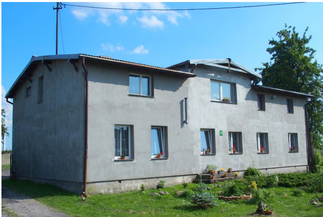
Widok budynku od północy
