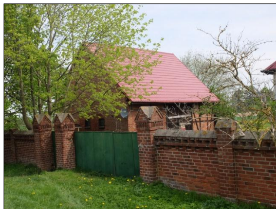
Fot. 7 Ogrodzenie z cegły oraz budynek ujęty w GEZ (16-UP) Źródło: archiwum własne
