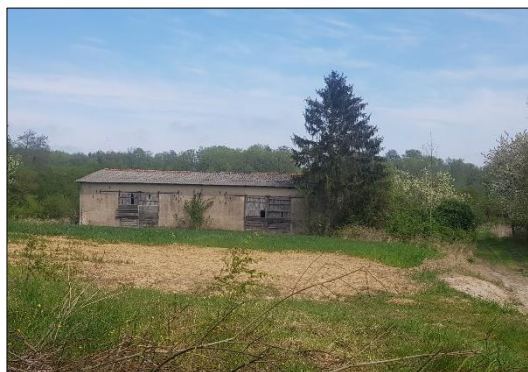
Fot. 2 Budynek gospodarczy na dz. nr 38/5, obręb Rusowo Źródło: archiwum własne
