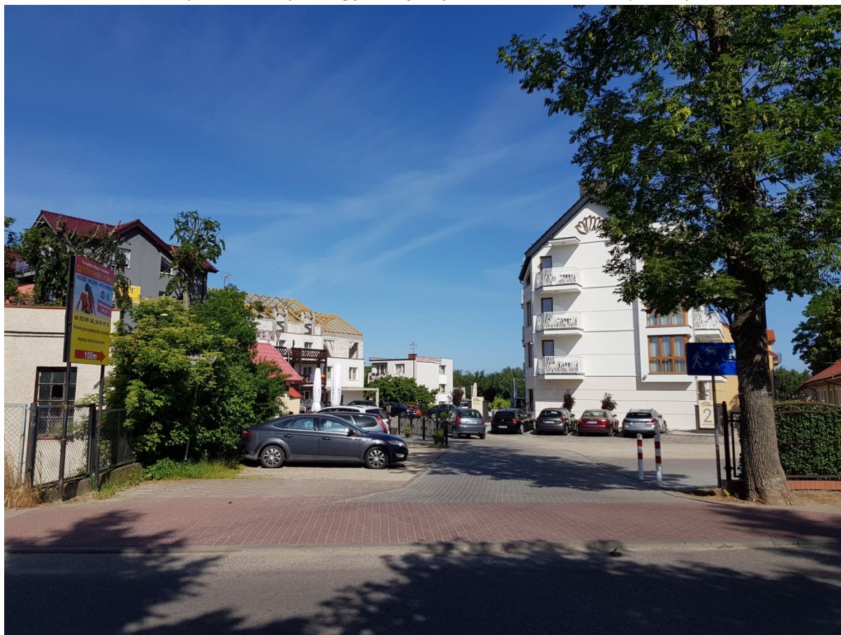
Fot. 1. Zjazd z ul. Rolnej na drogę wewnętrzną 5 KDW (widok w kierunku północnym).
