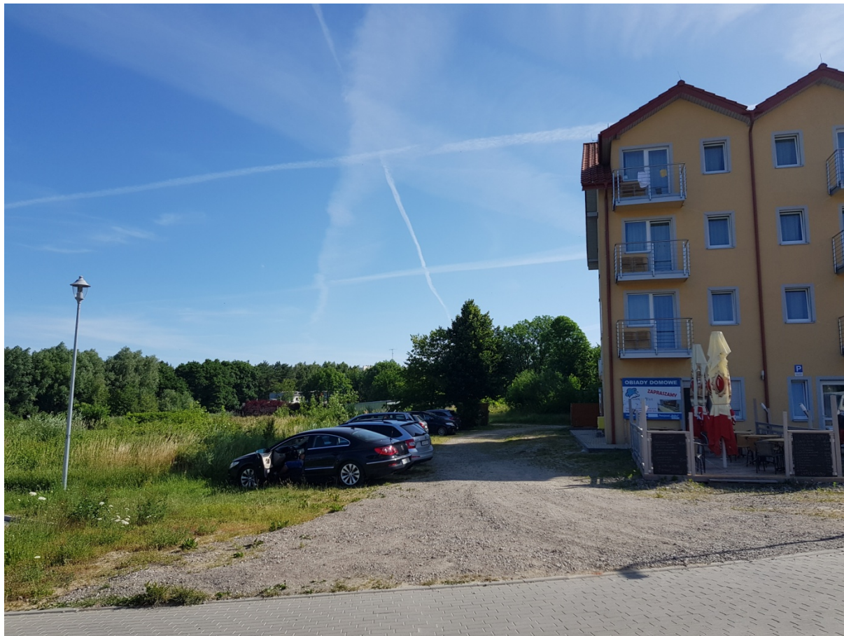
Fot. 5. Fragment drogi wewnętrznej 5KDW pomiędzy terenami 6UT/U i 7UT/U a granicą mpzp (widok w kierunku wschodnim).
