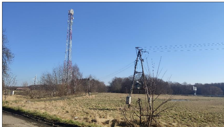
Fot. 1 Stacja bazowa na dz. nr 49/6, obręb Kukinia Źródło: archiwum własne
