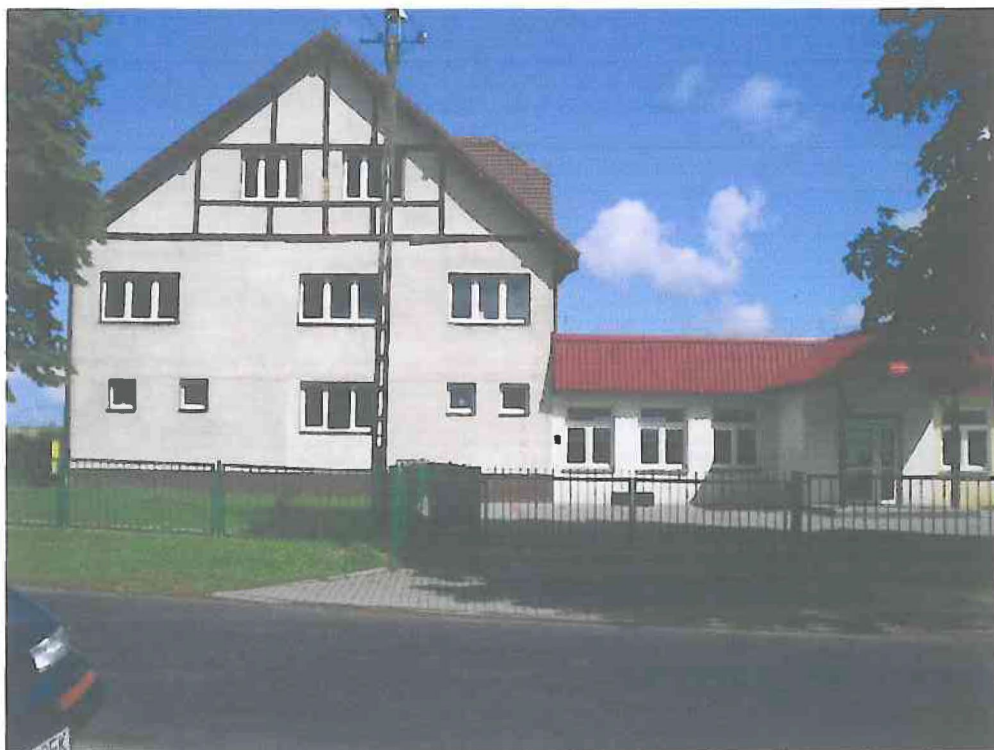
WIDOK OD STRONY POŁUDNIOWEJ
