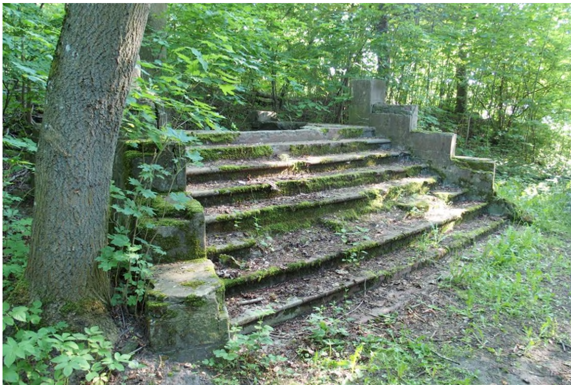
Widok budynku od północnego - wschodu
