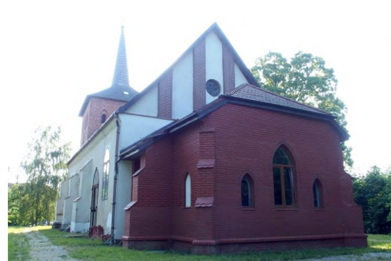
Widok od południowego - wschodu
