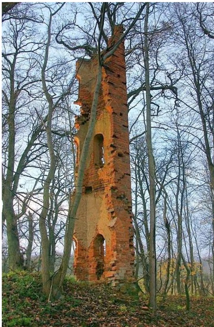
Widok od północnego - zachodu
