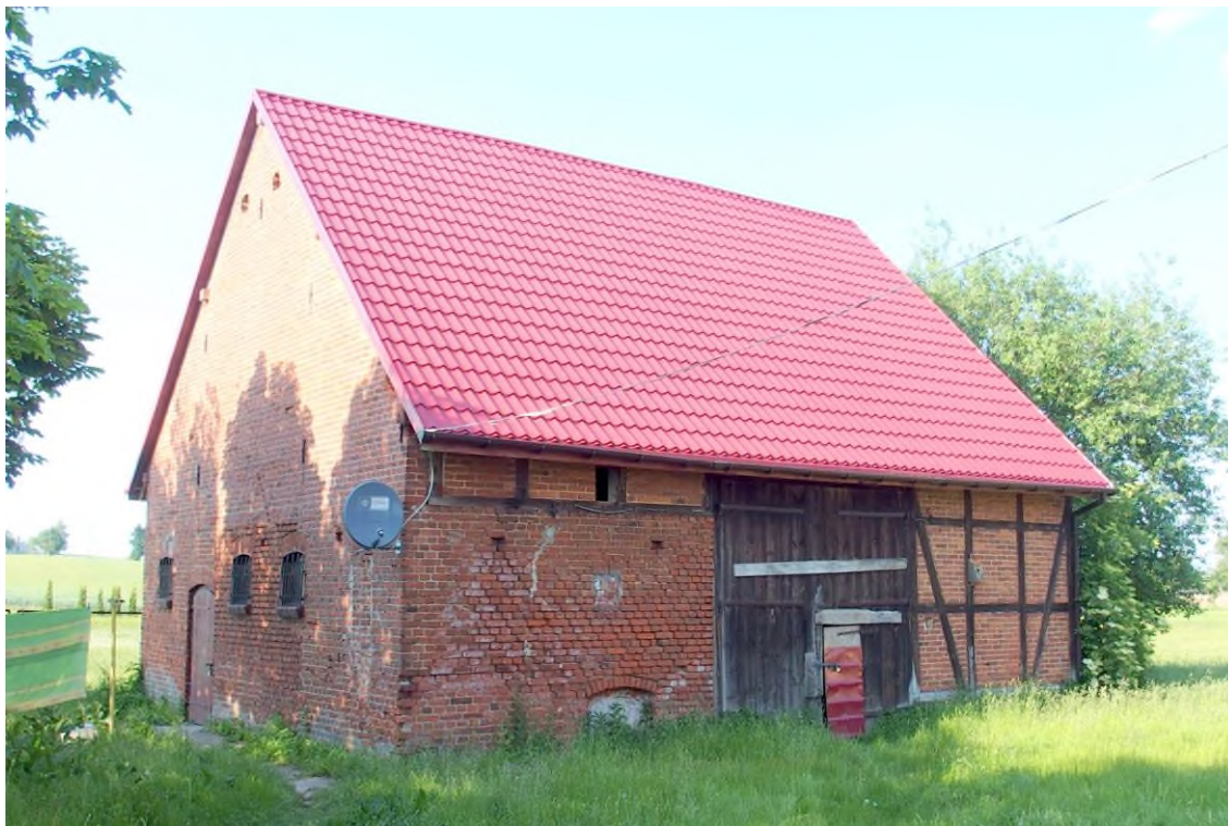
Widok budynku od południowego - zachodu
