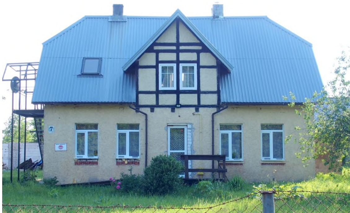
Widok budynku od wschodu
