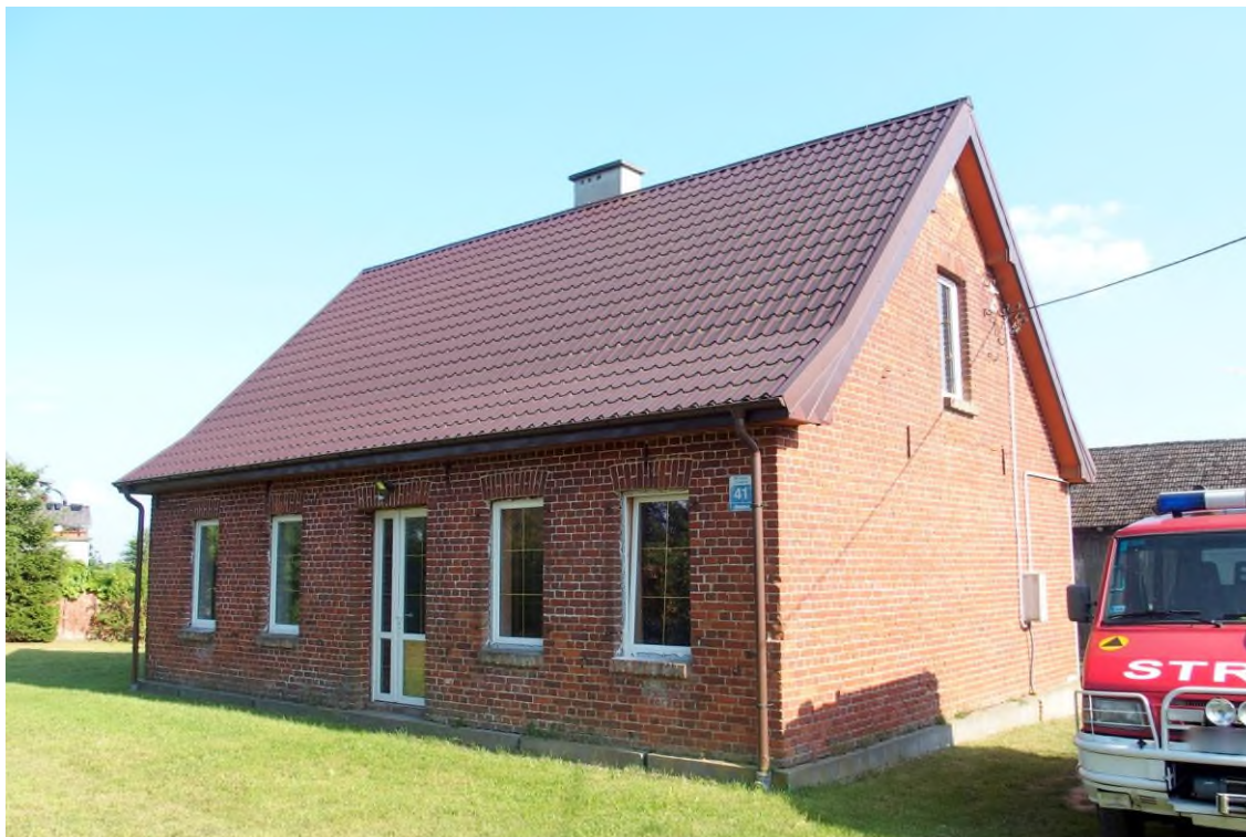
Widok budynku od północnego - zachodu
