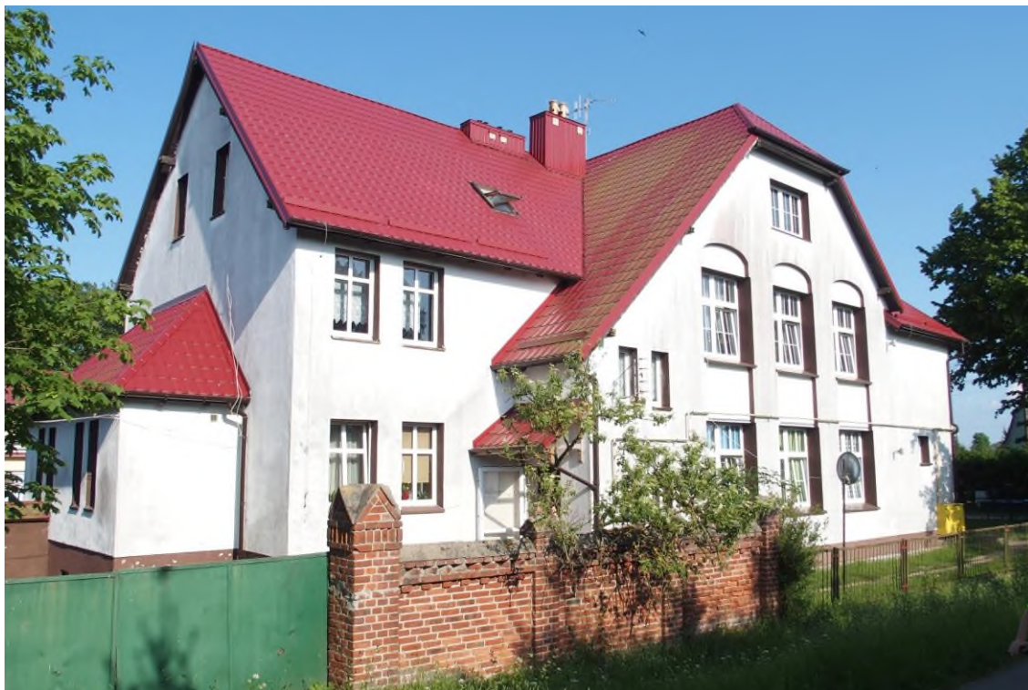
Widok budynku od północnego - zachodu
