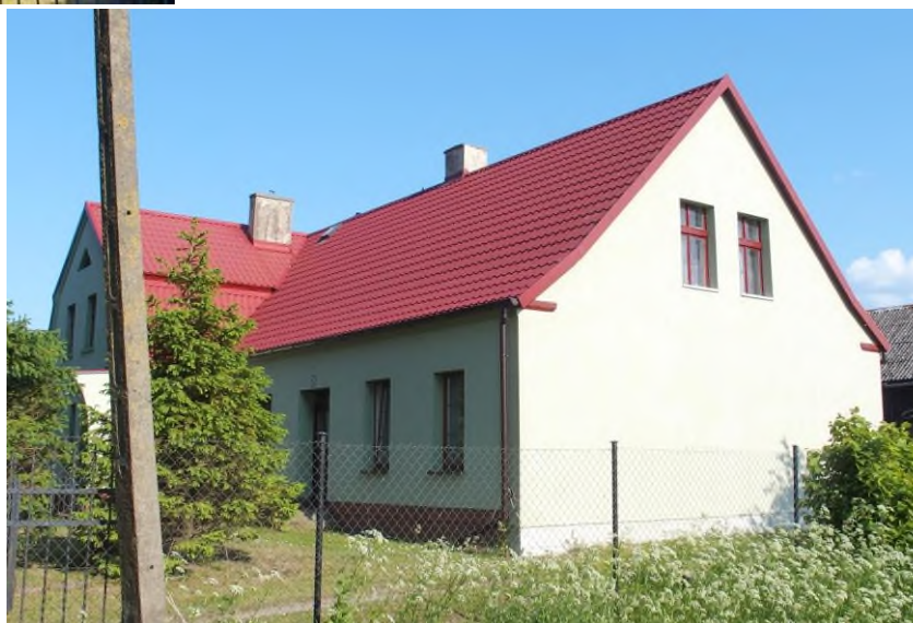
Widok budynku od północnego - zachodu
