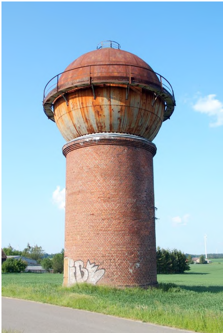
Widok od południowego - zachodu
