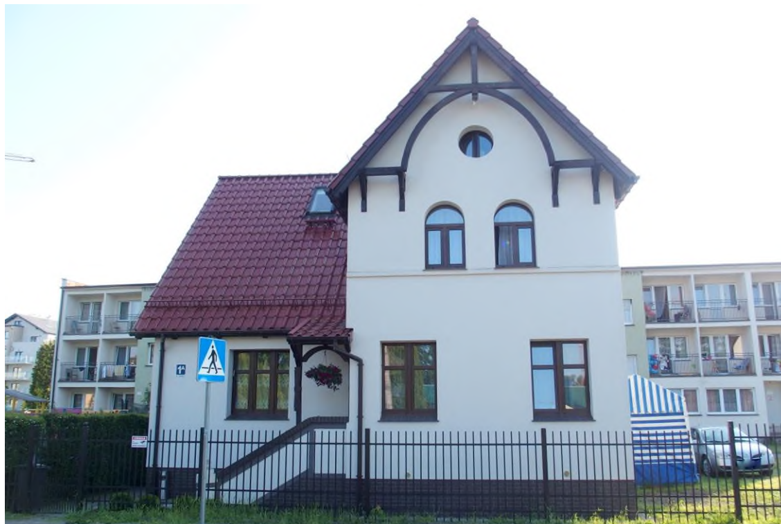
Widok budynku od północnego - wschodu
