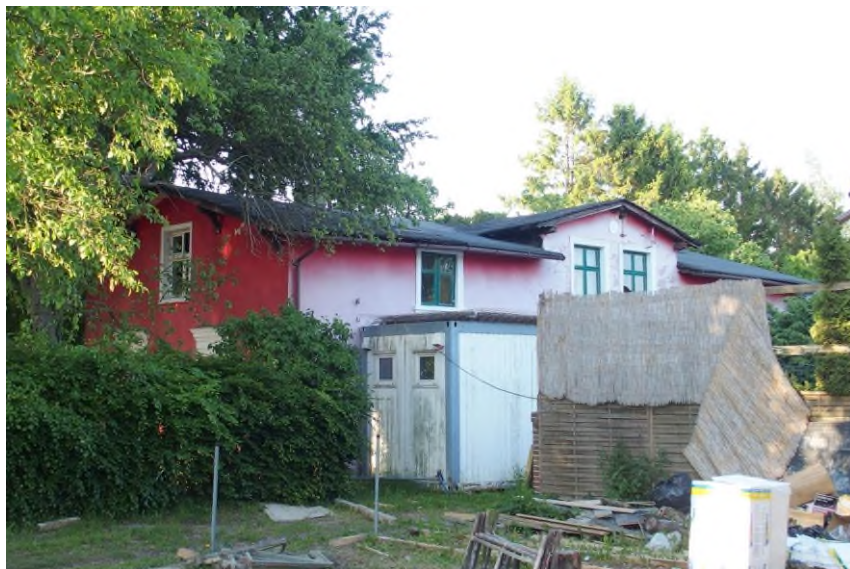
Widok budynku od południowego - zachodu
