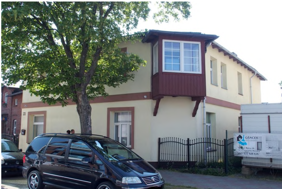
Widok budynku od północnego - zachodu
