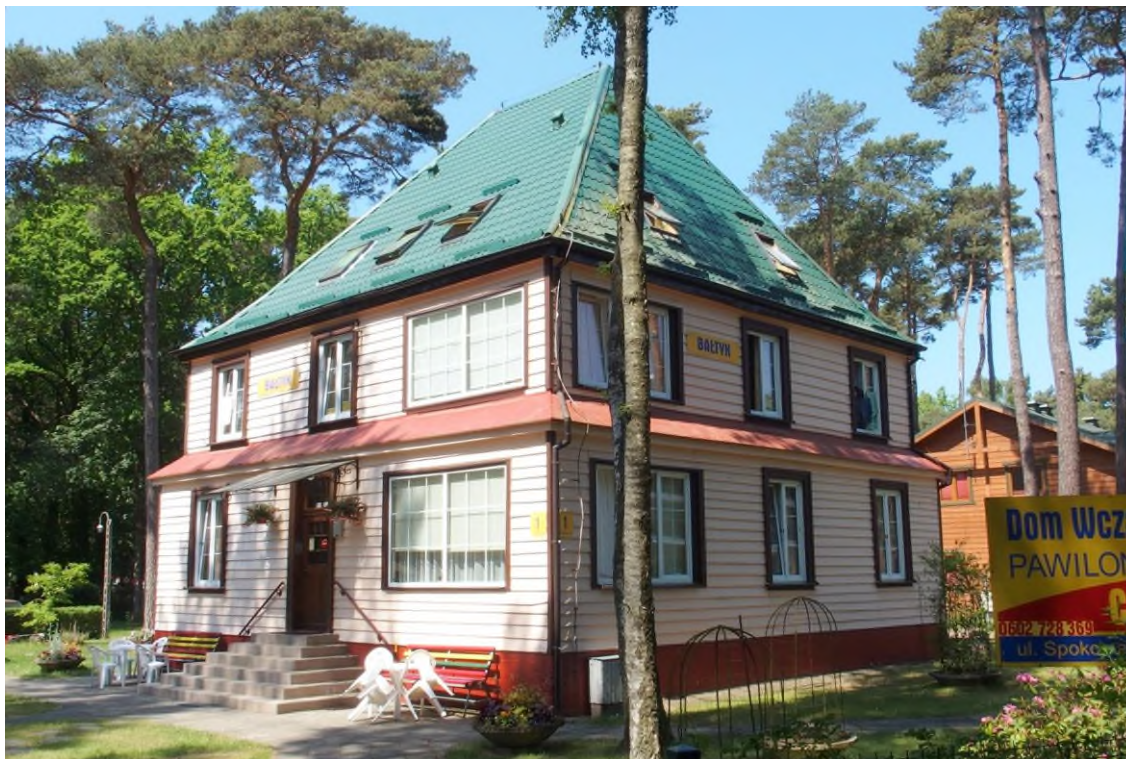
Widok budynku od południowego - wschodu
