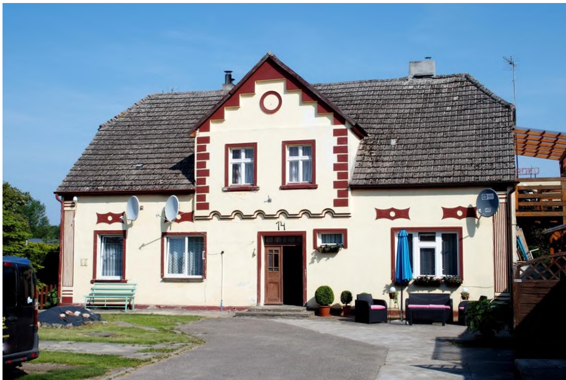
Widok budynku od południowego - wschodu
