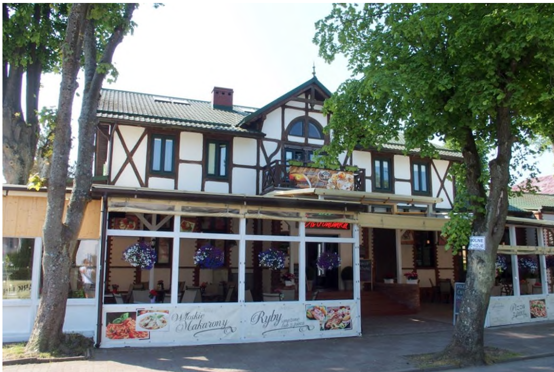
Widok budynku od północy
