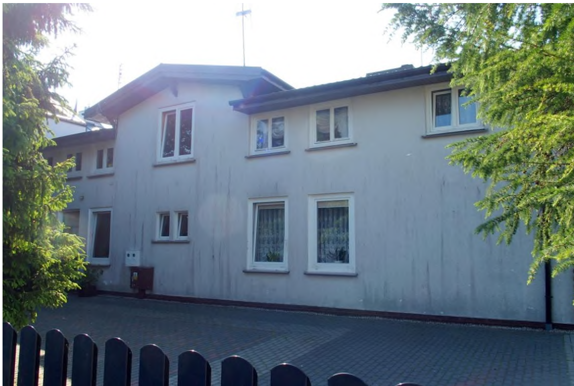
Widok budynku od północnego - zachodu
