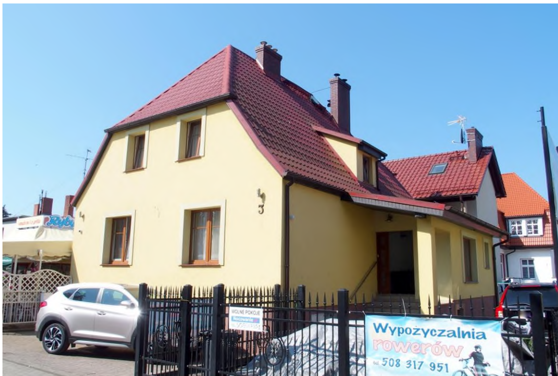
Widok budynku od północnego - wschodu
