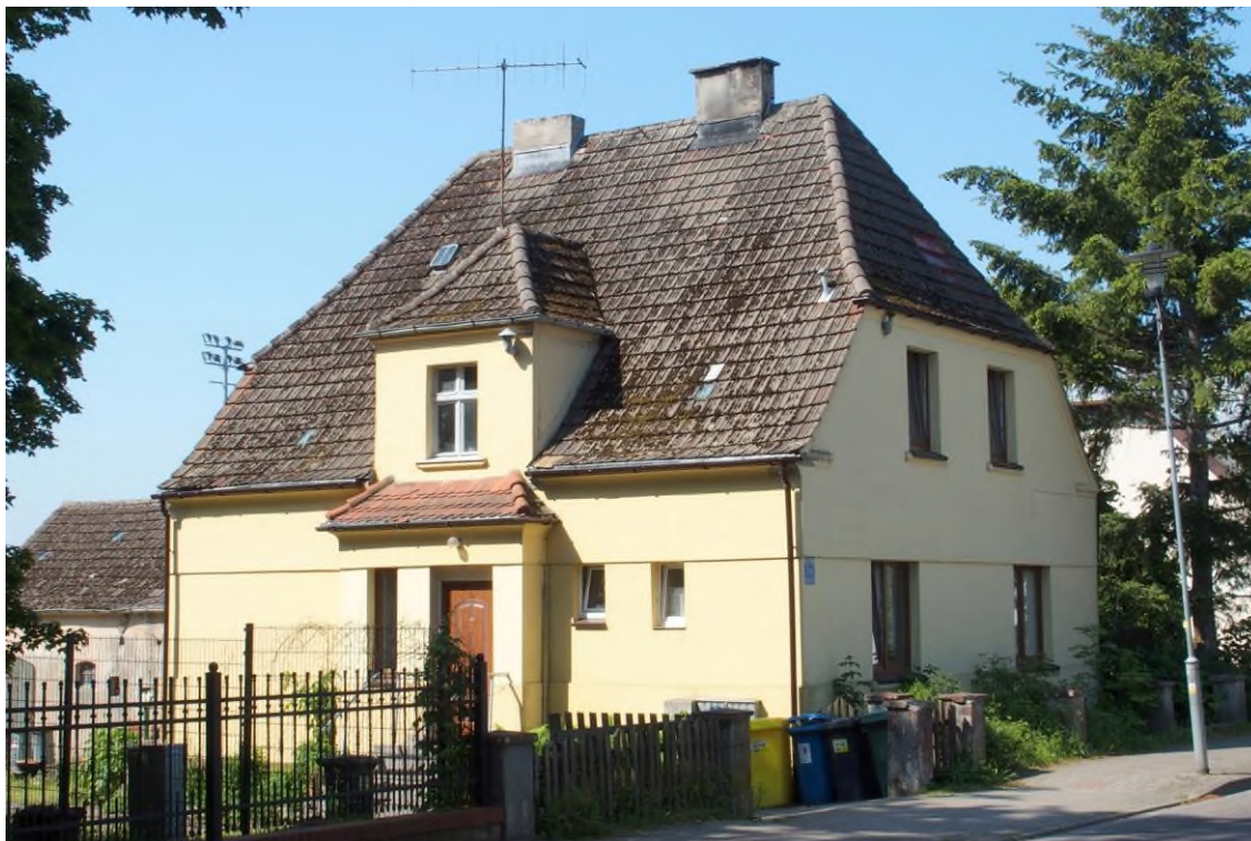
Widok budynku od północnego - wschodu
