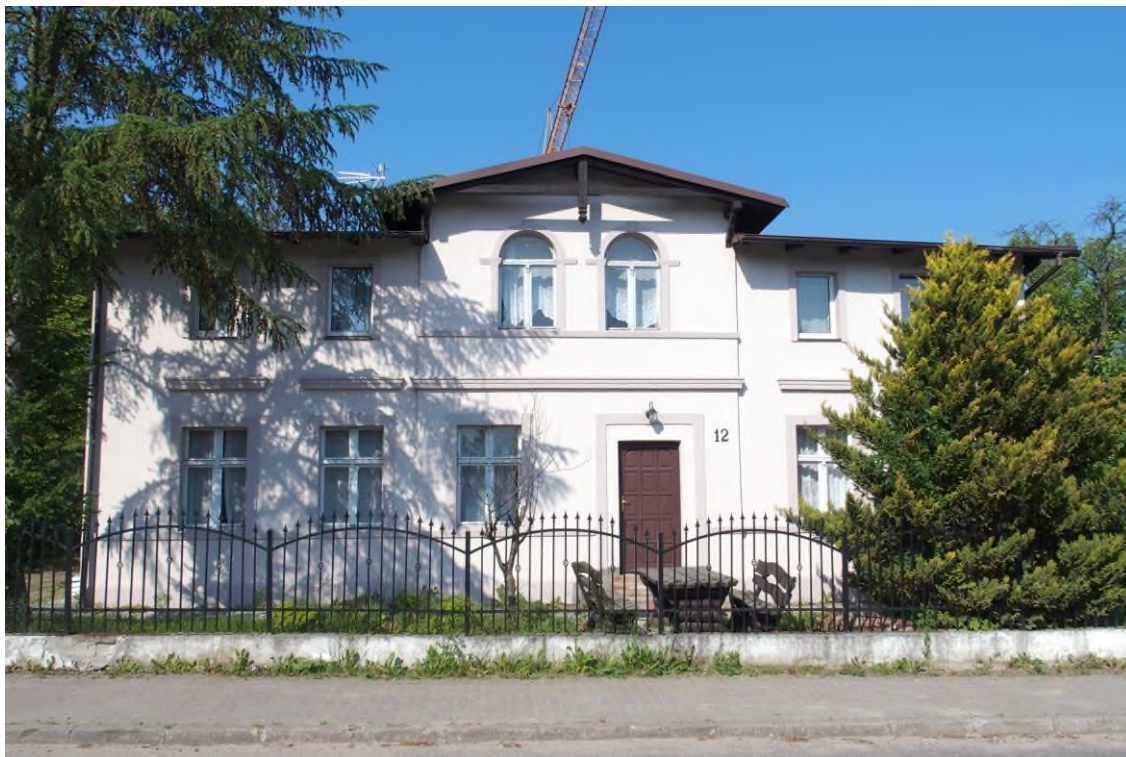
Widok budynku od północnego - wschodu
