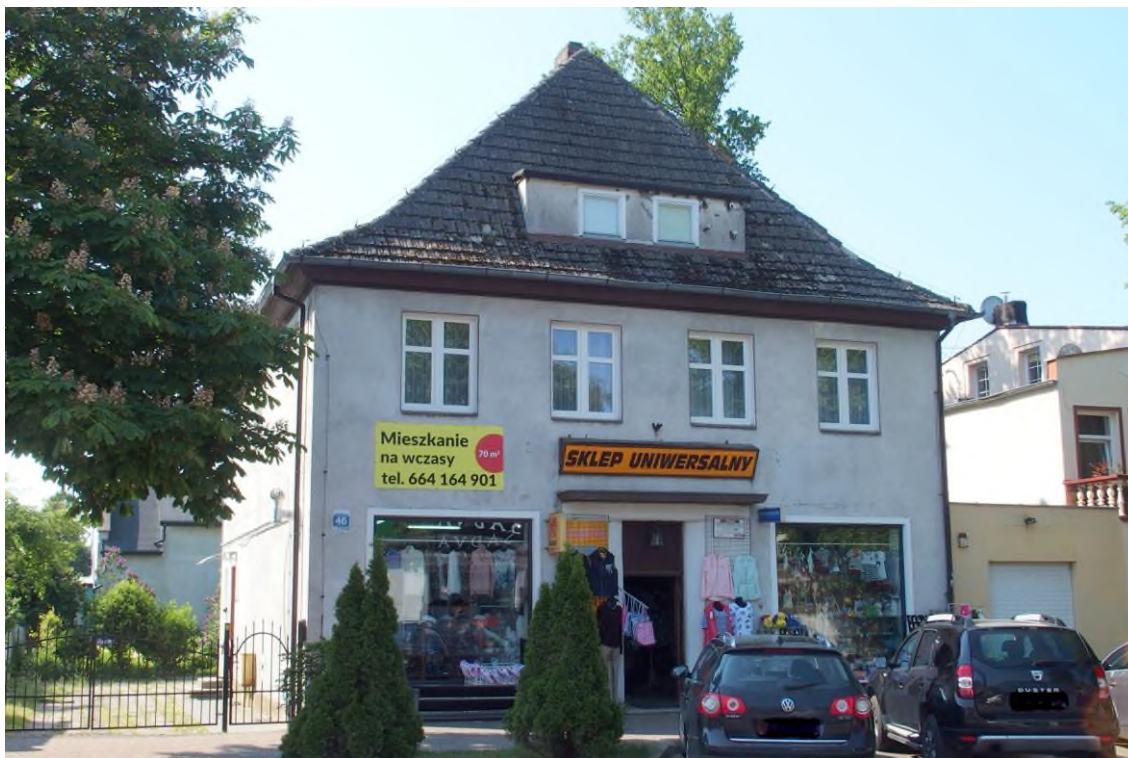
Widok budynku od północy
