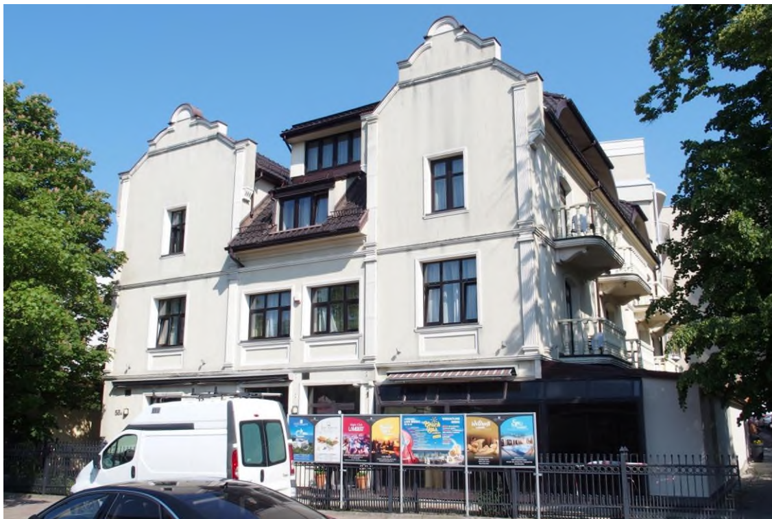
Widok budynku od południowego - wschodu
