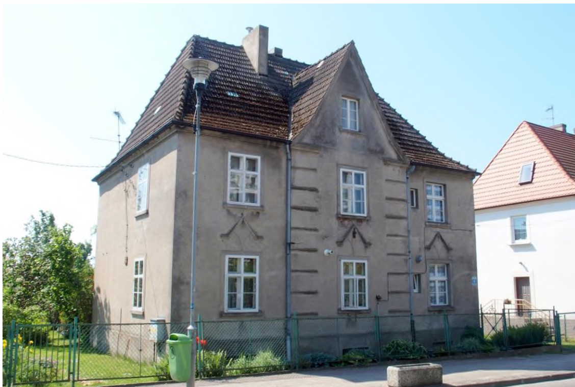
Widok budynku od północy
