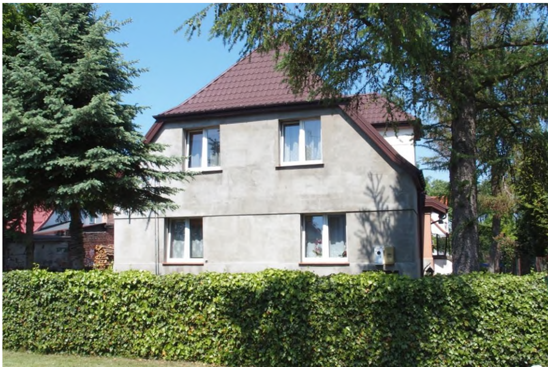
Widok budynku od południowego - wschodu
