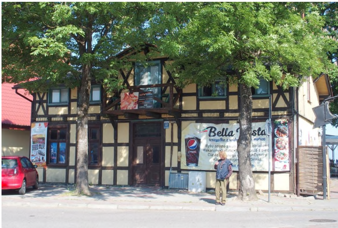
Widok budynku od południowego - wschodu
