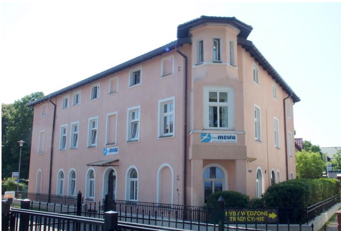
Widok budynku od północnego - zachodu
