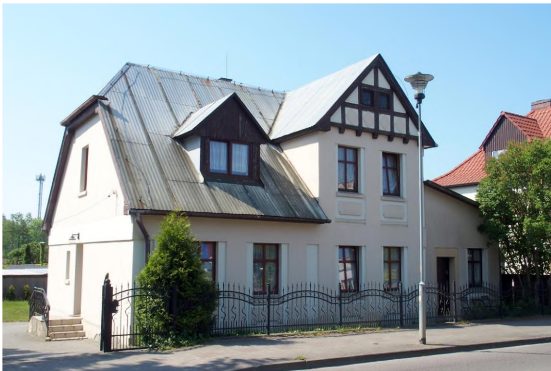
Widok budynku od północnego - wschodu
