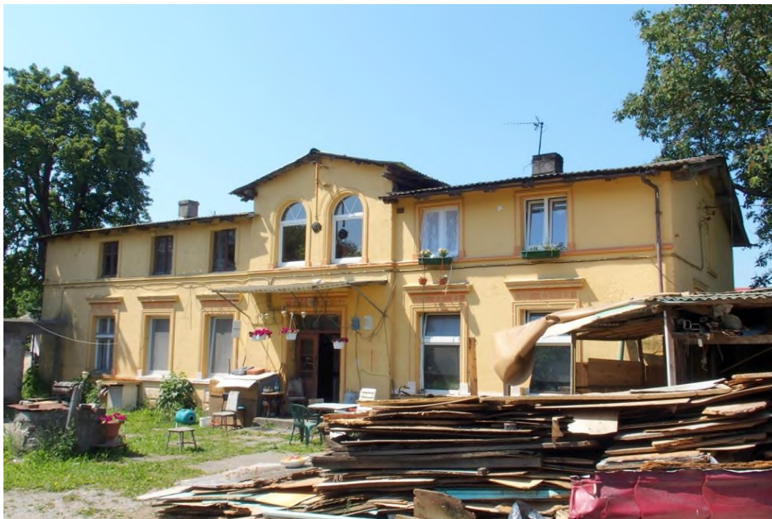
Widok budynku od północnego - wschodu
