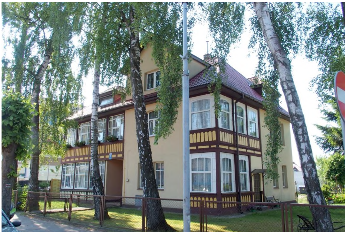
Widok budynku od północnego - zachodu
