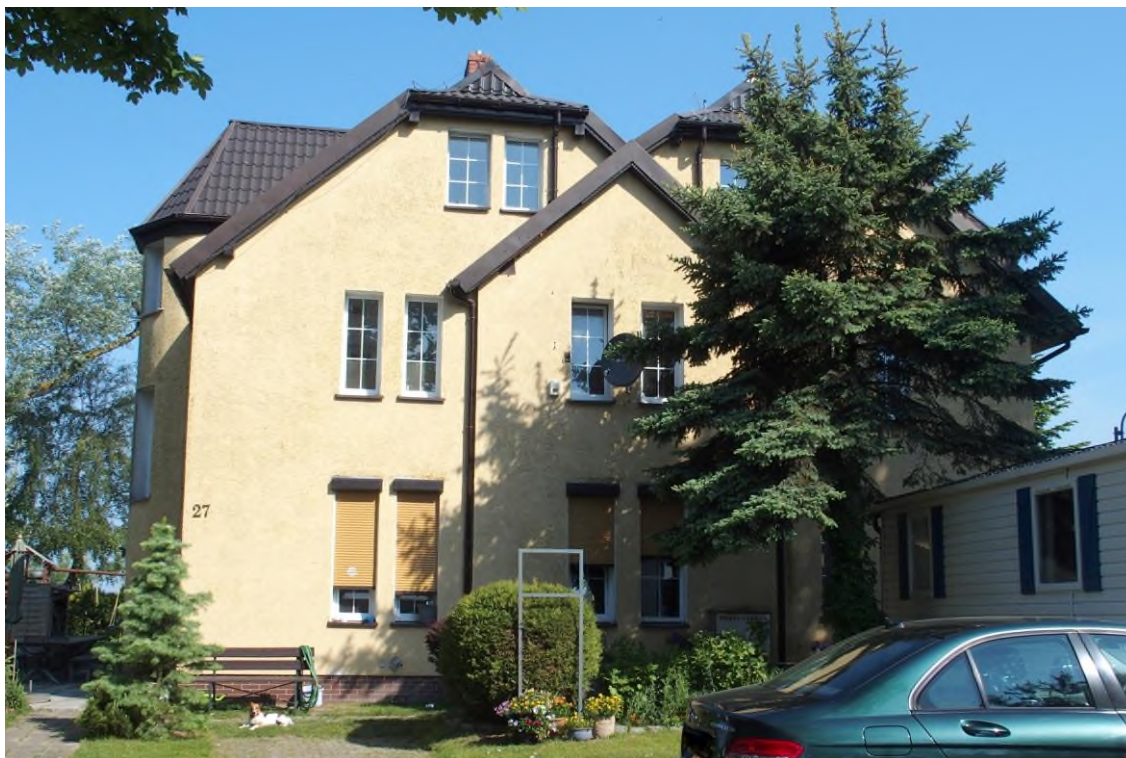
Widok budynku od południowego - wschodu
