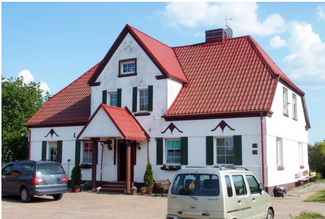
Widok budynku od północnego - zachodu
