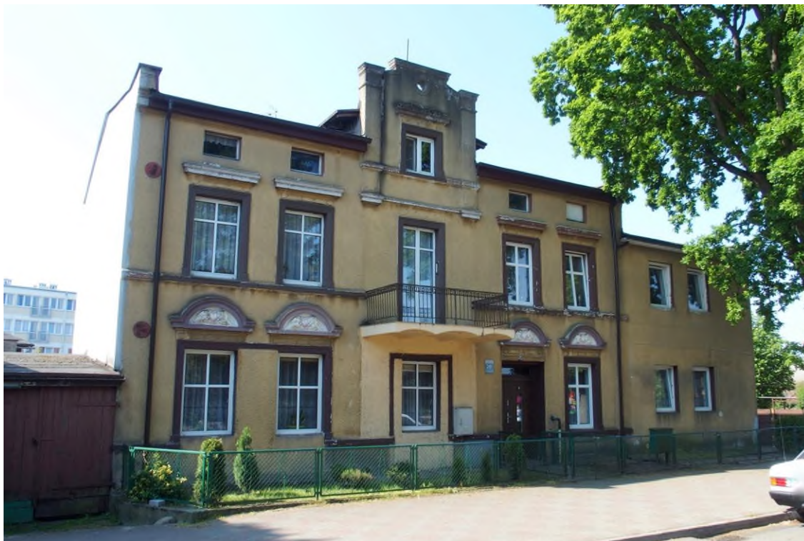
Widok budynku od północnego - wschodu
