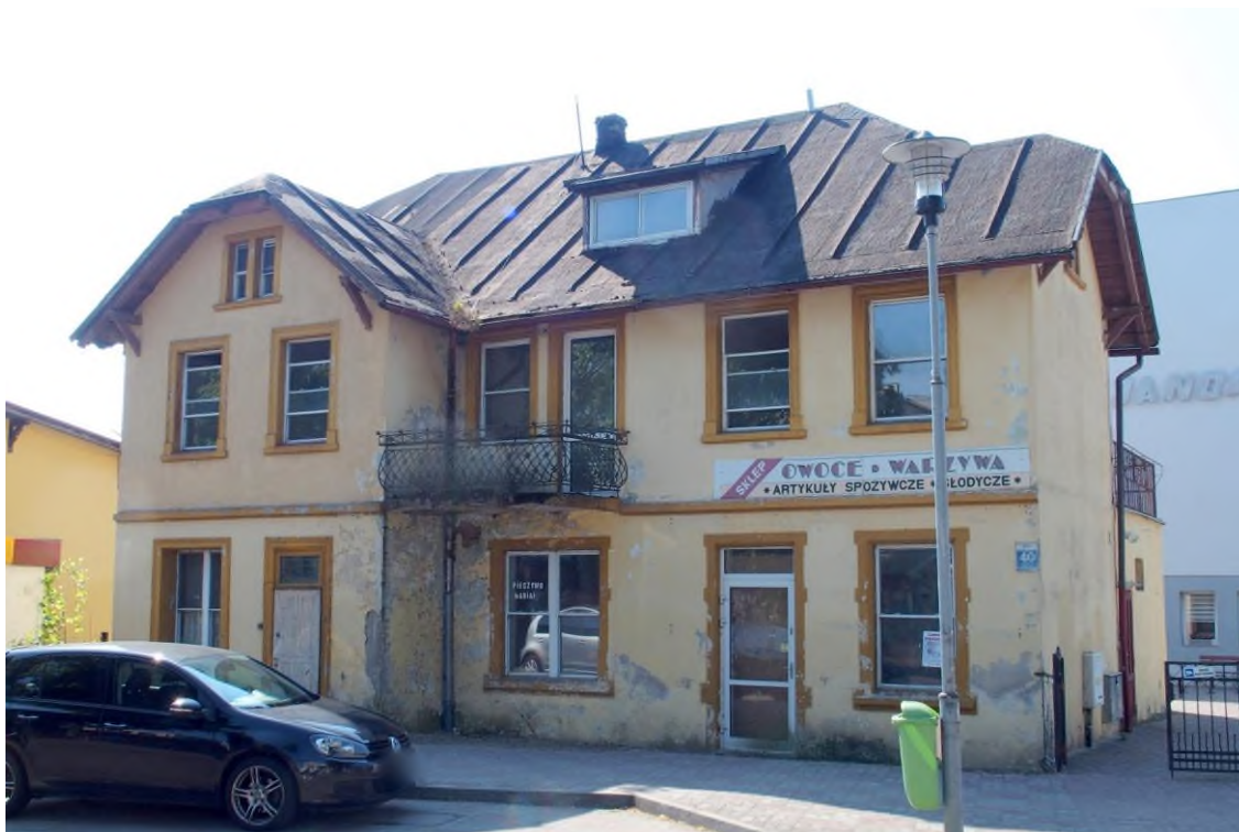
Widok budynku od północnego - zachodu
