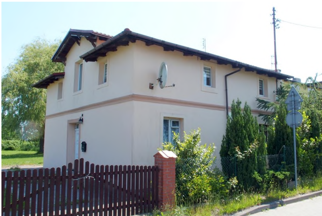
Widok budynku od północnego - zachodu
