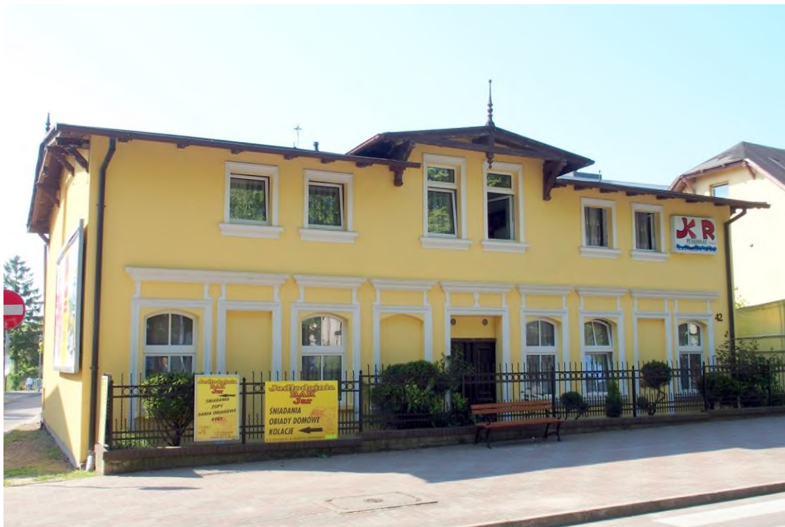
Widok budynku od północy
