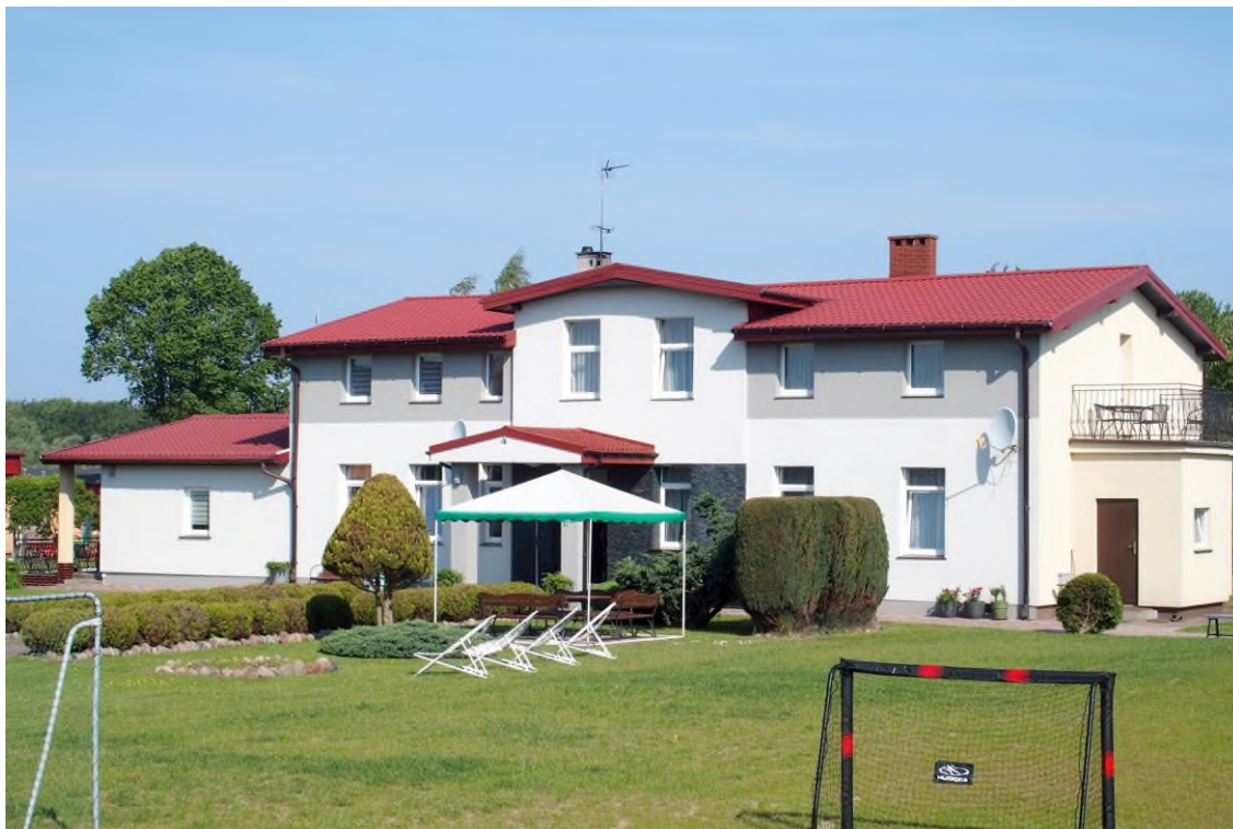
Widok budynku od południowego - wschodu
