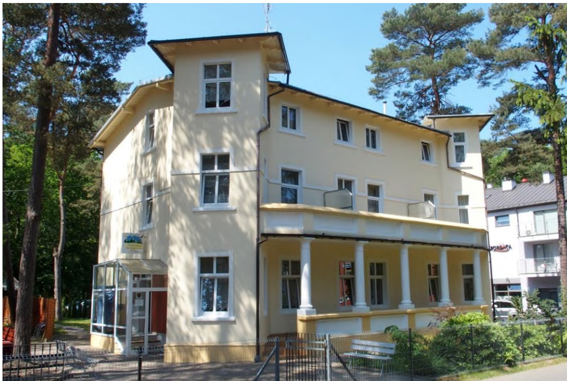
Widok budynku od południowego - wschodu
