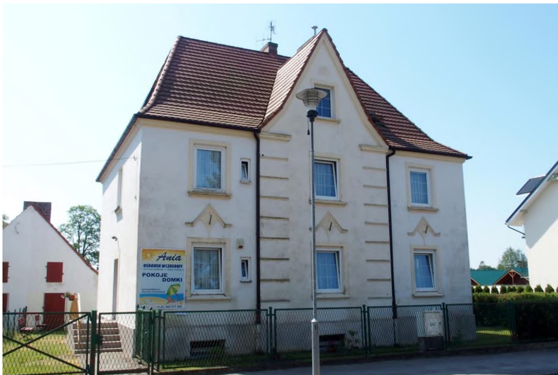
Widok budynku od północy
