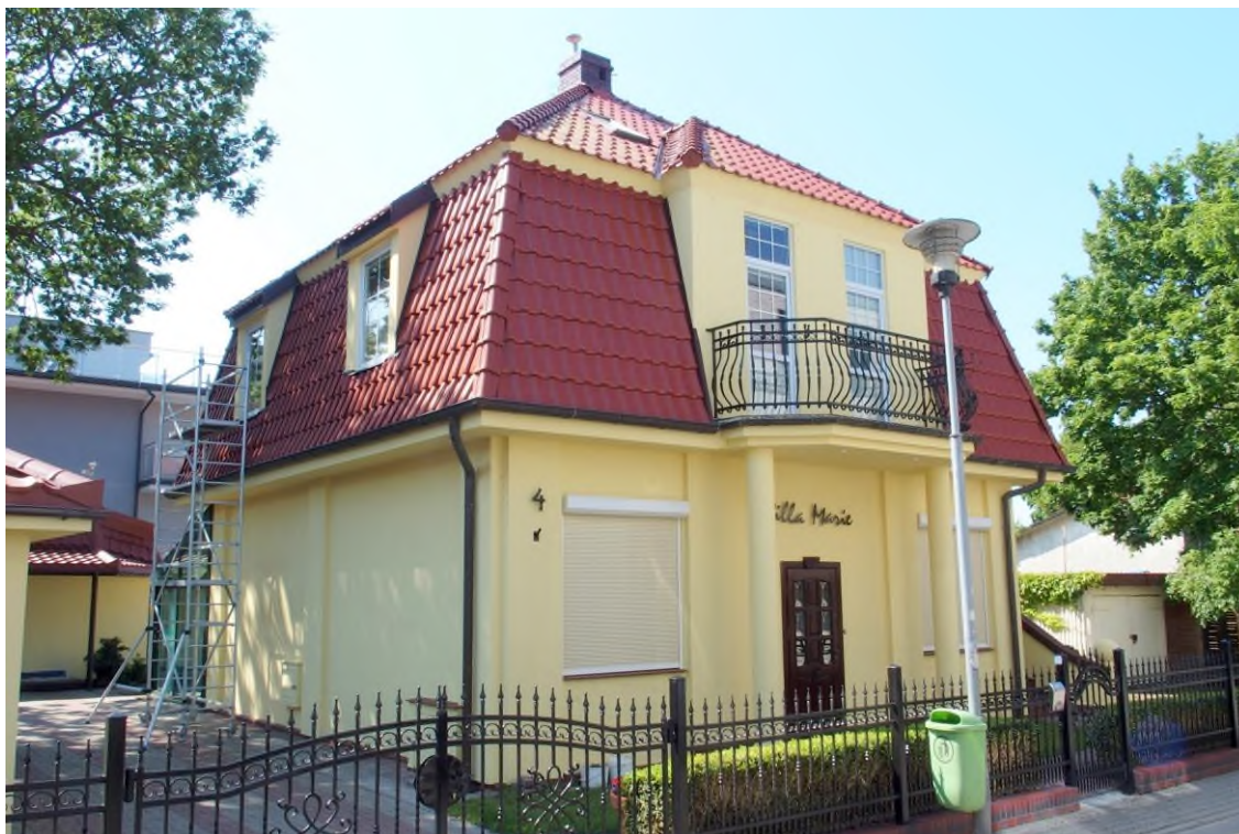
Widok budynku od północnego - wschodu
