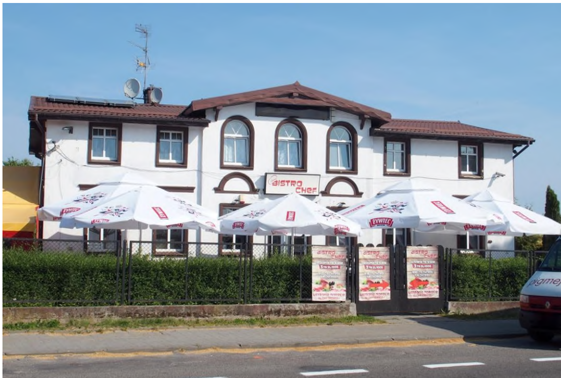
Widok budynku od południowego - wschodu
