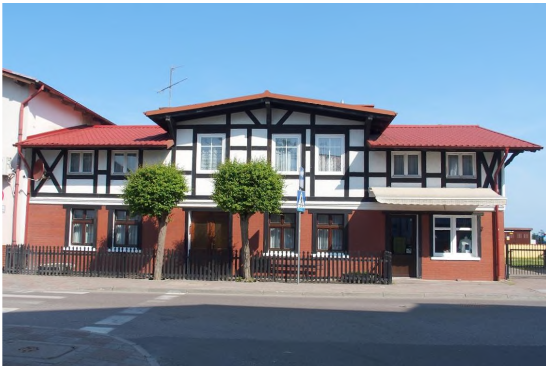
Widok budynku od południowego - wschodu
