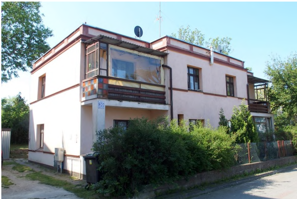
Widok budynku od północnego - wschodu
