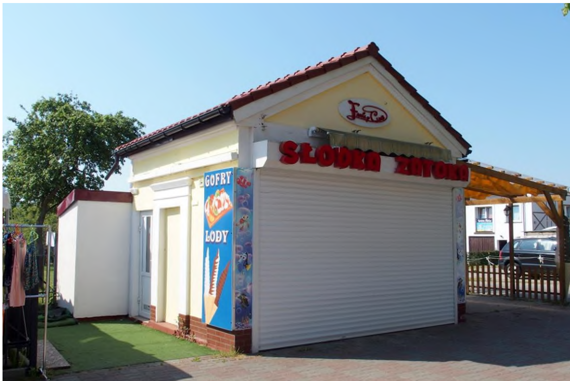
Widok budynku od północnego - wschodu
