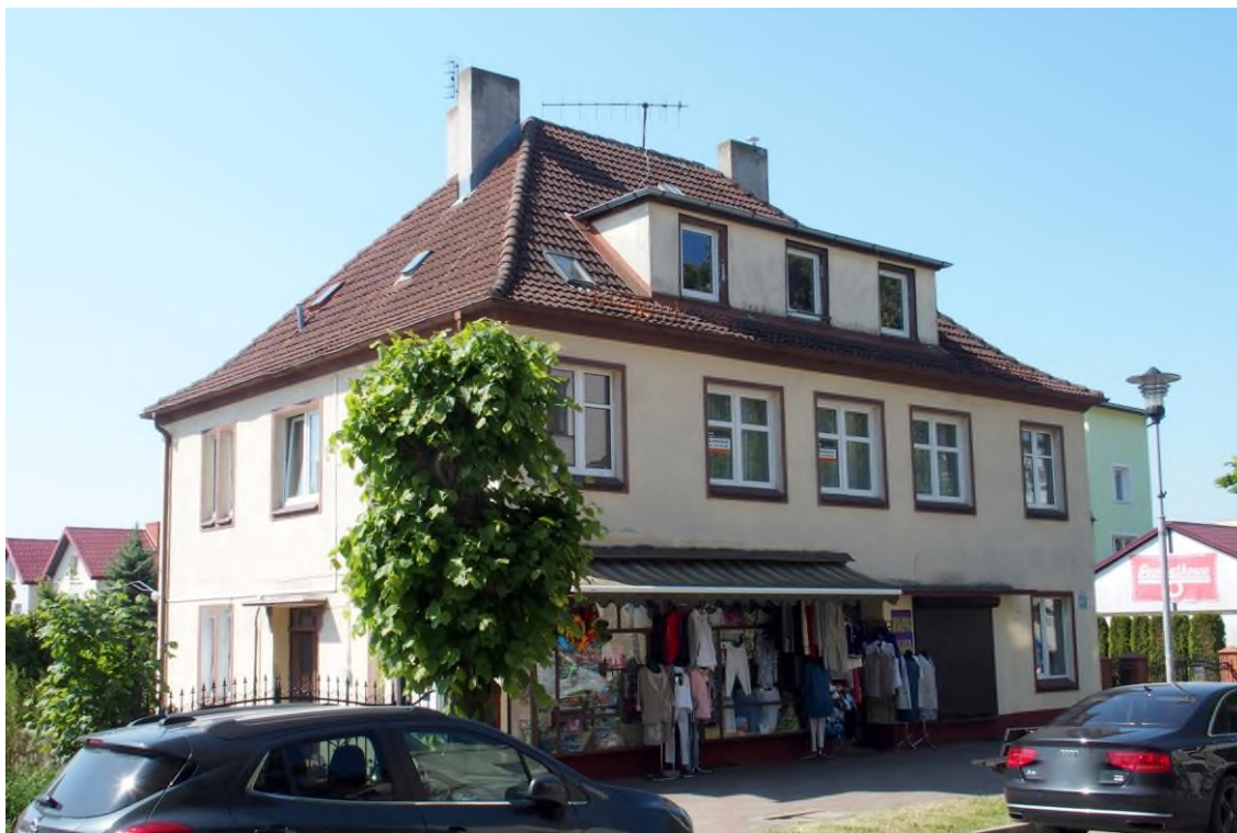
Widok budynku od północnego - wschodu
