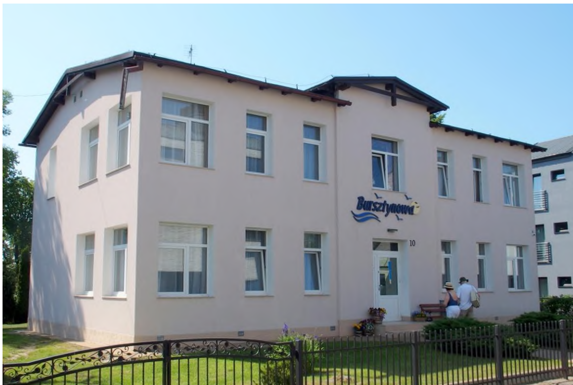
Widok budynku od północy
