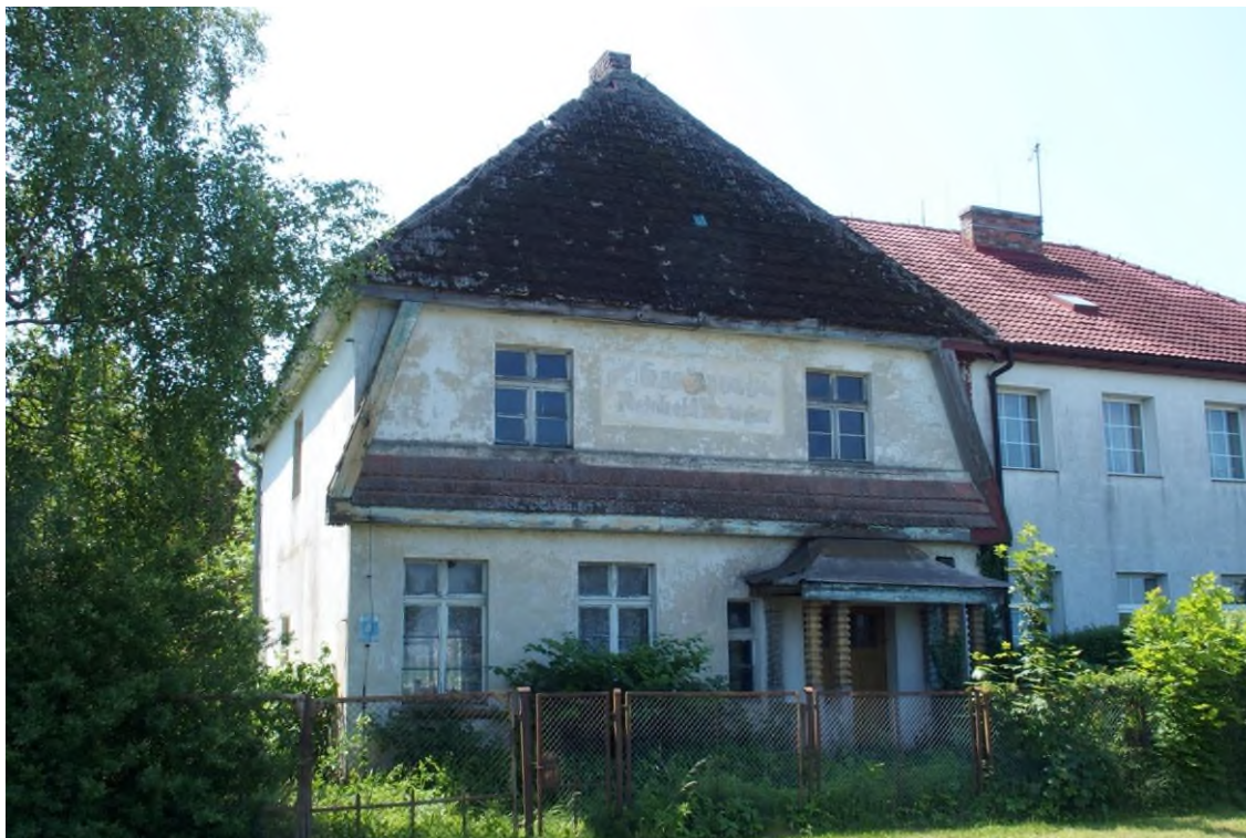
Widok budynku od północnego - wschodu
