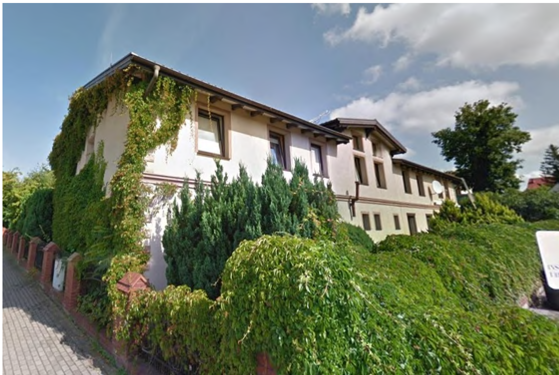
Widok budynku od południowego - zachodu
