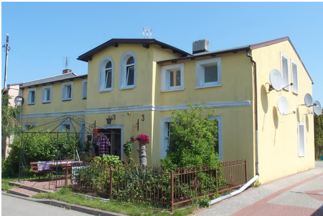
Widok budynku od południowego - zachodu
