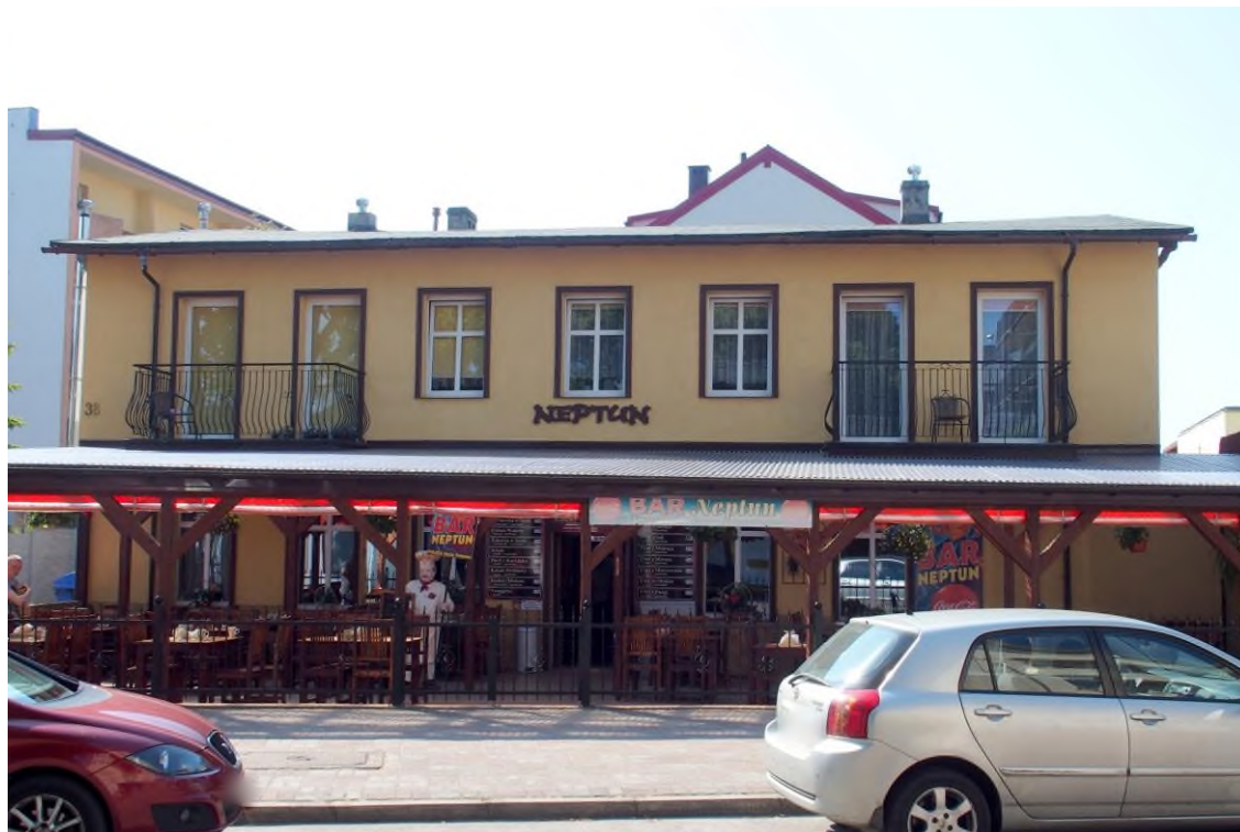
Widok budynku od północy
