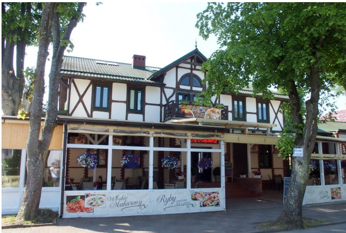
Widok budynku od północy
