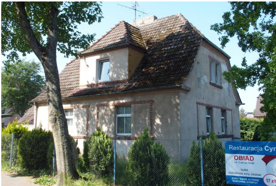
Widok budynku od północnego - wschodu
