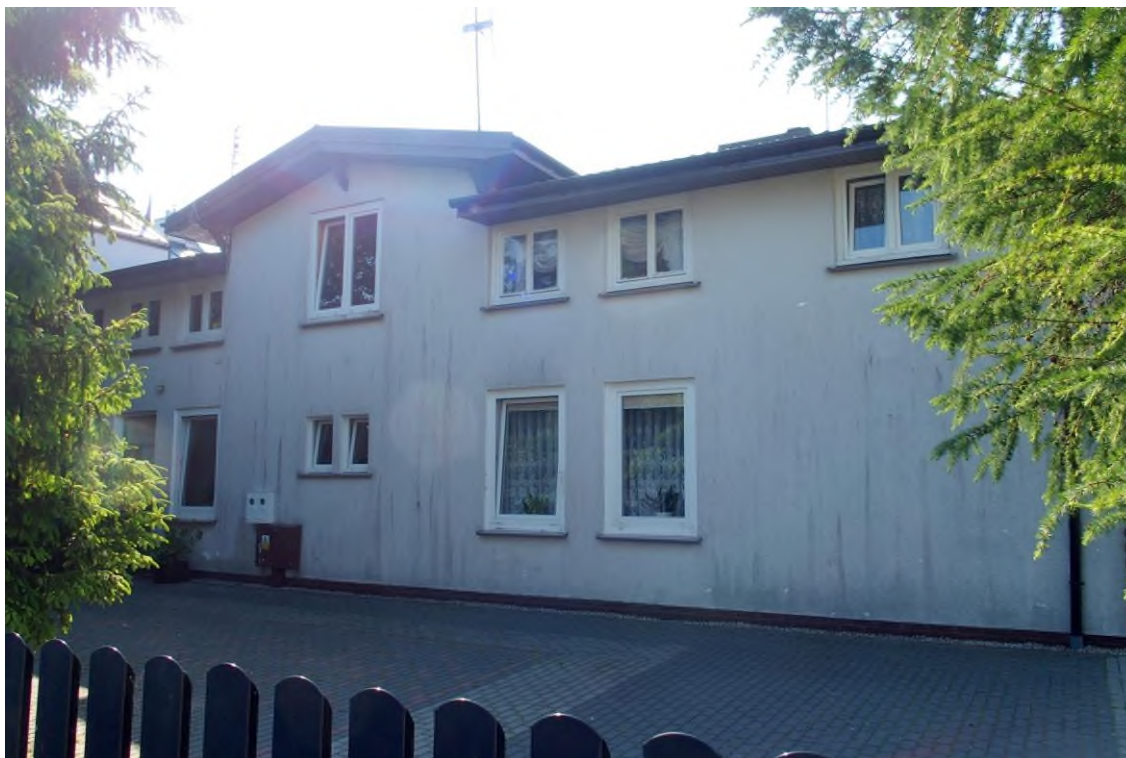
Widok budynku od północnego - zachodu
