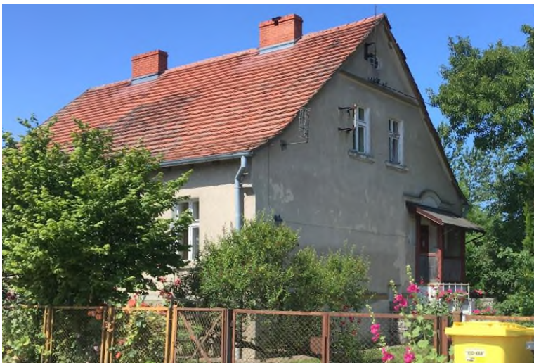
Widok budynku mieszkalnego od południowego - wschodu
