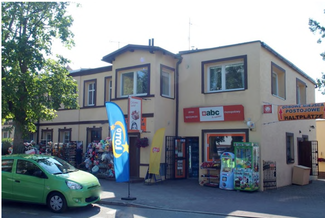
Widok budynku od północnego - zachodu
