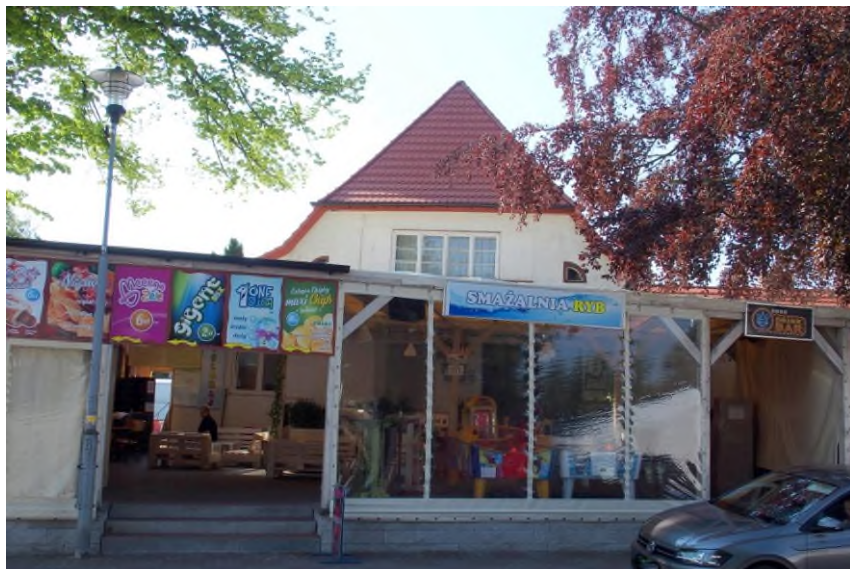
Widok budynku od północy
