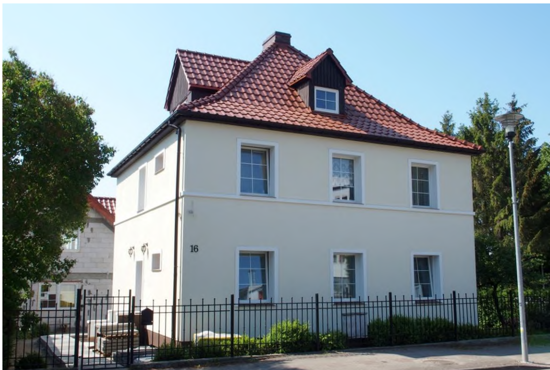
Widok budynku od północnego - wschodu
