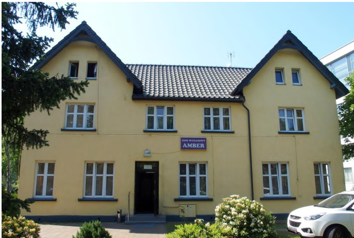
Widok budynku od północy
