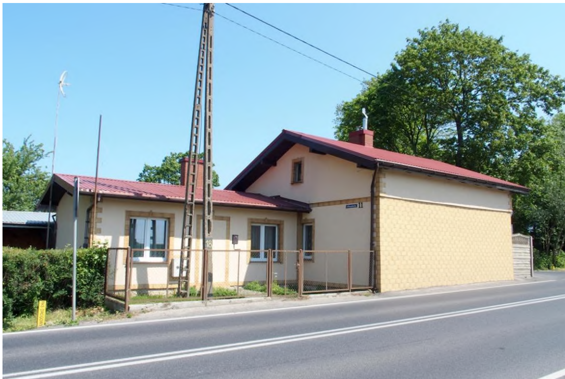
Widok budynku od południowego - zachodu
