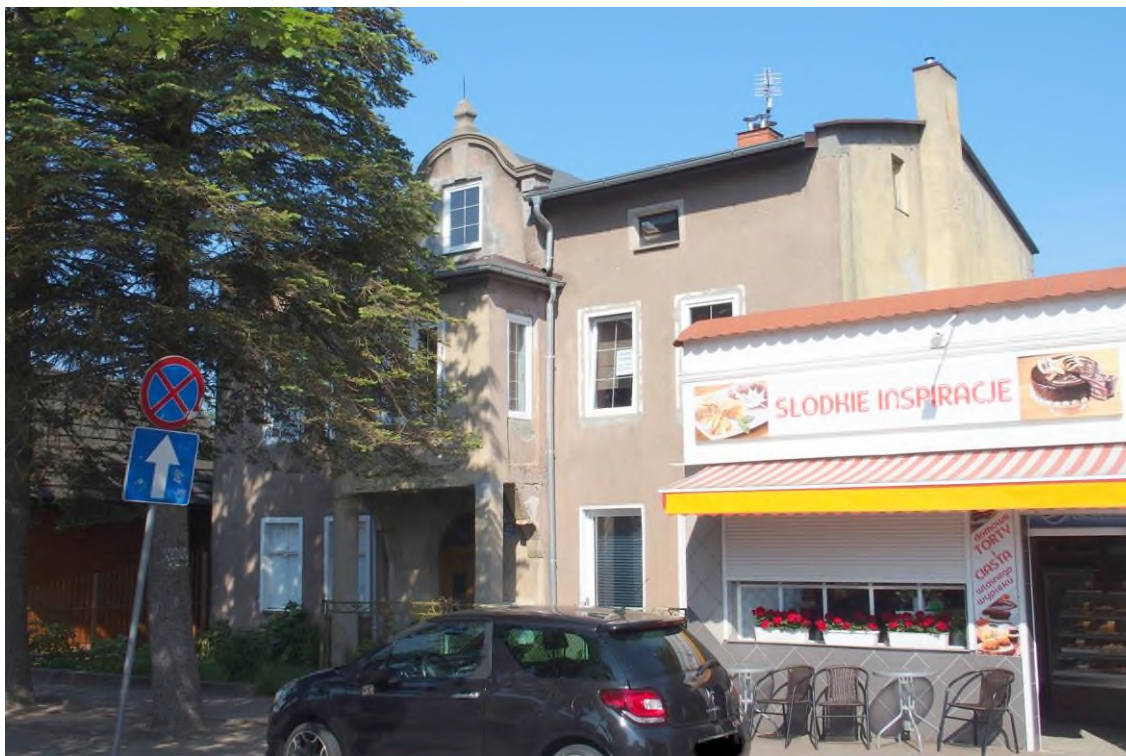
Widok budynku od wschodu
