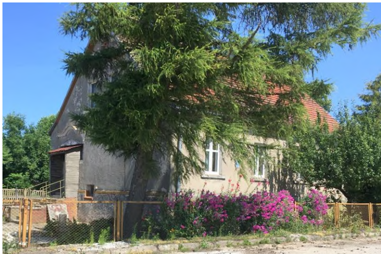
Widok budynku mieszkalnego od południowego - zachodu
