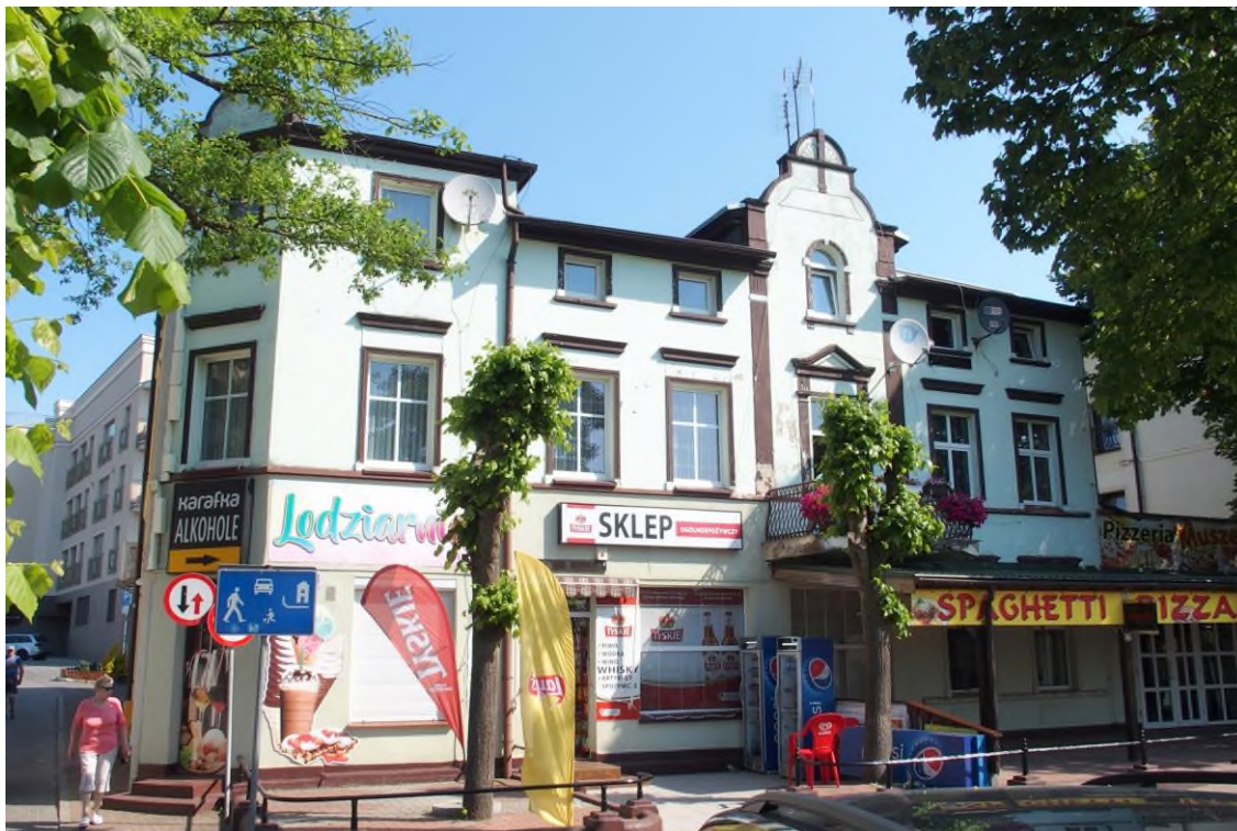
Widok budynku od południowego - zachodu
