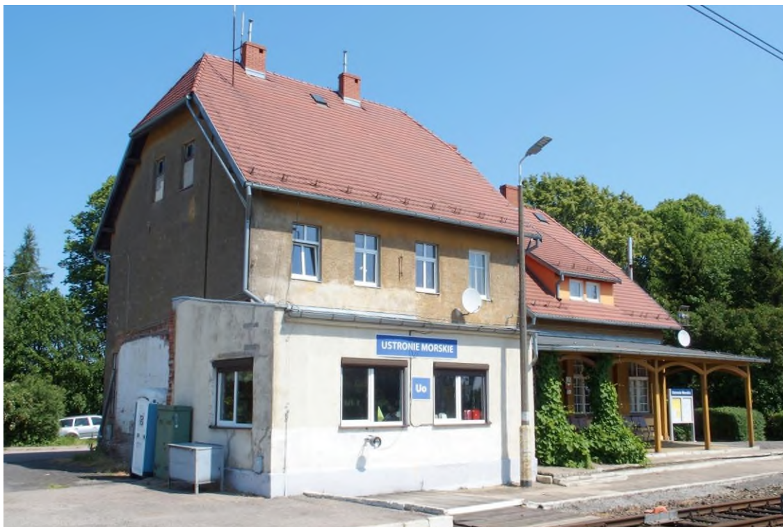
Widok budynku od południowego - zachodu
