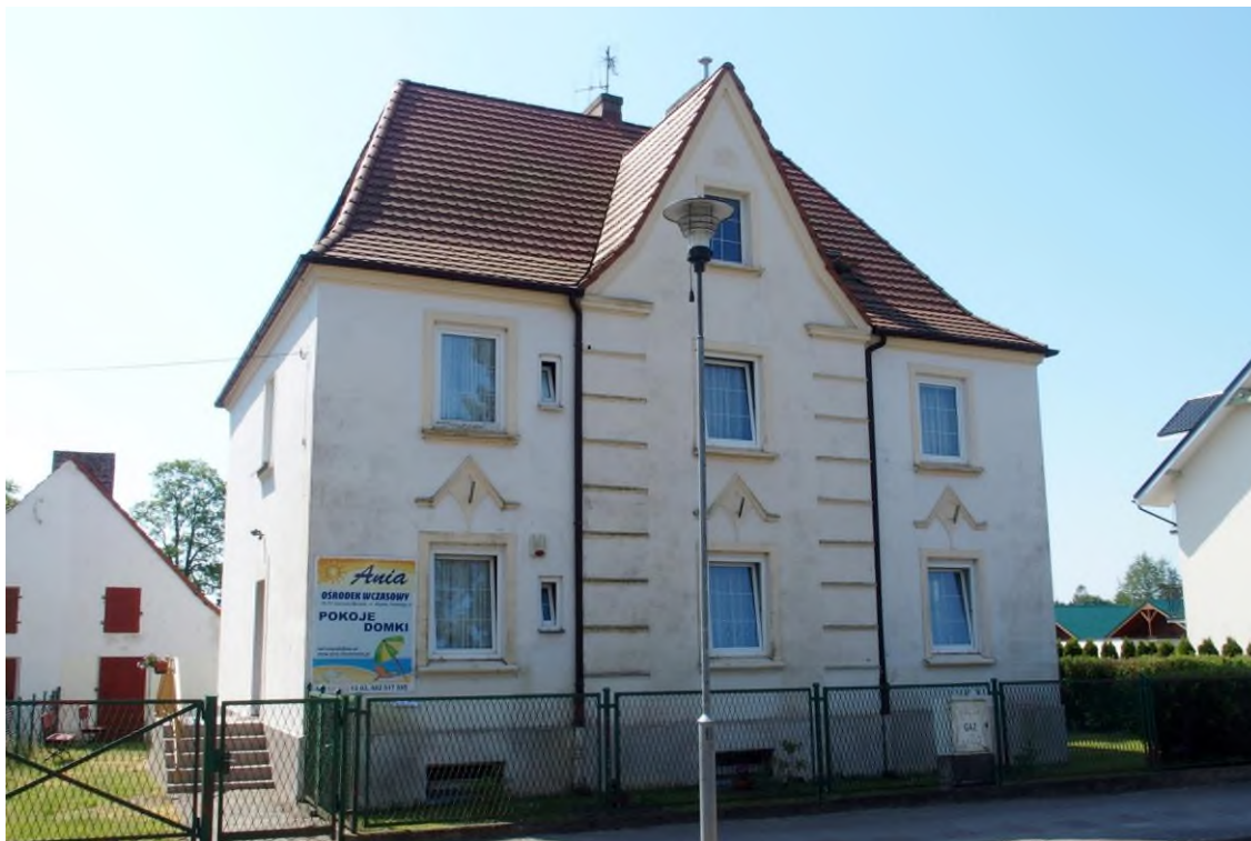
Widok budynku od północy
