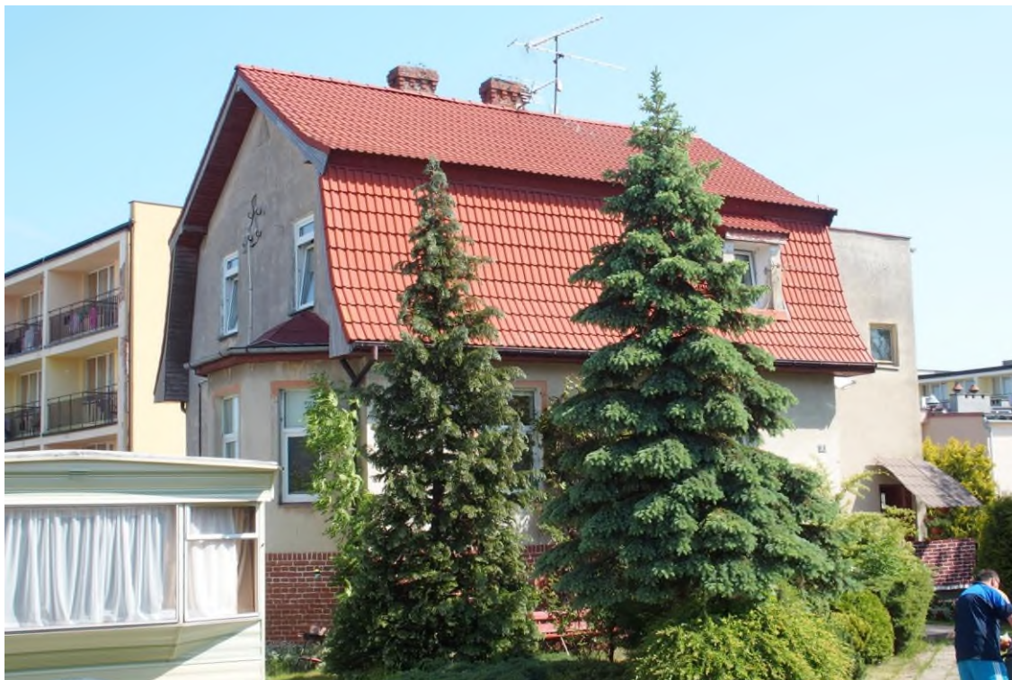
Widok budynku od południowego - zachodu
