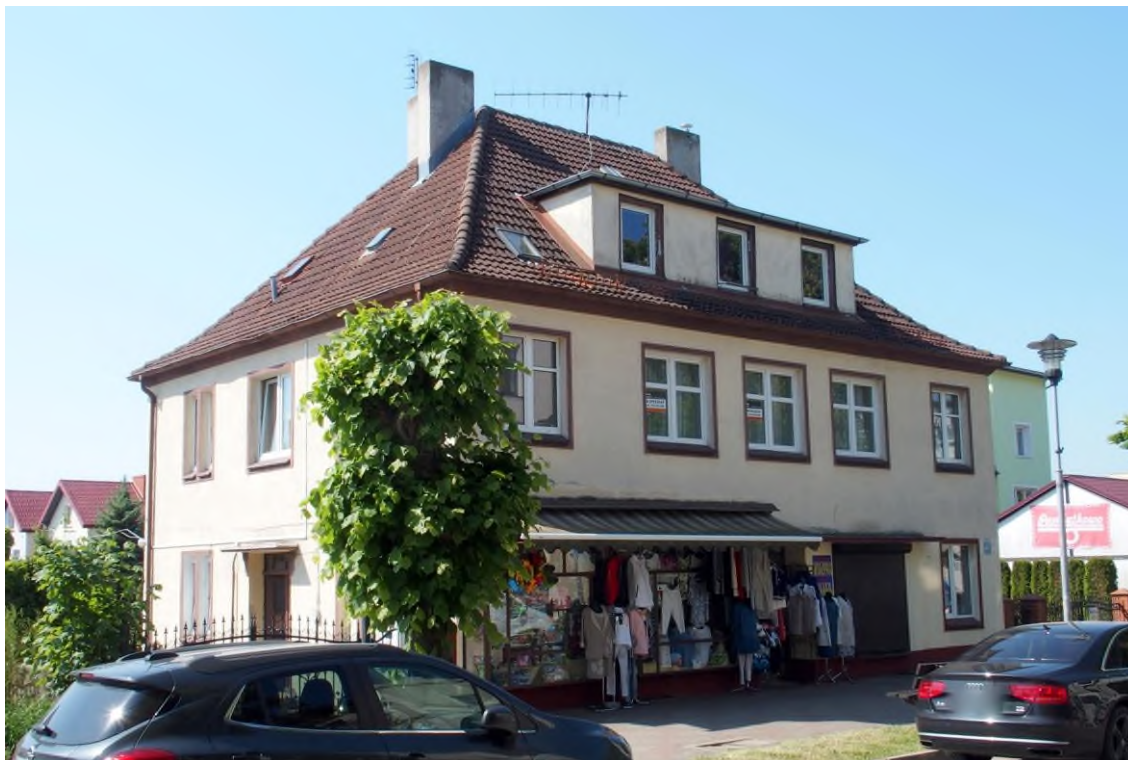
Widok budynku od północnego - wschodu
