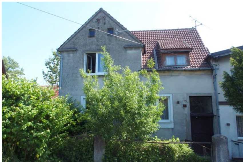
Widok budynku od południowego - zachodu
