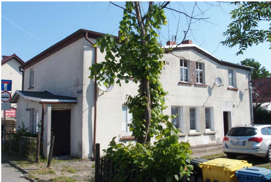
Widok budynku od południowego - zachodu
