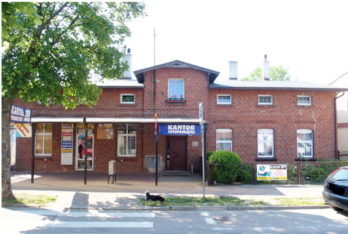
Widok budynku od północy
