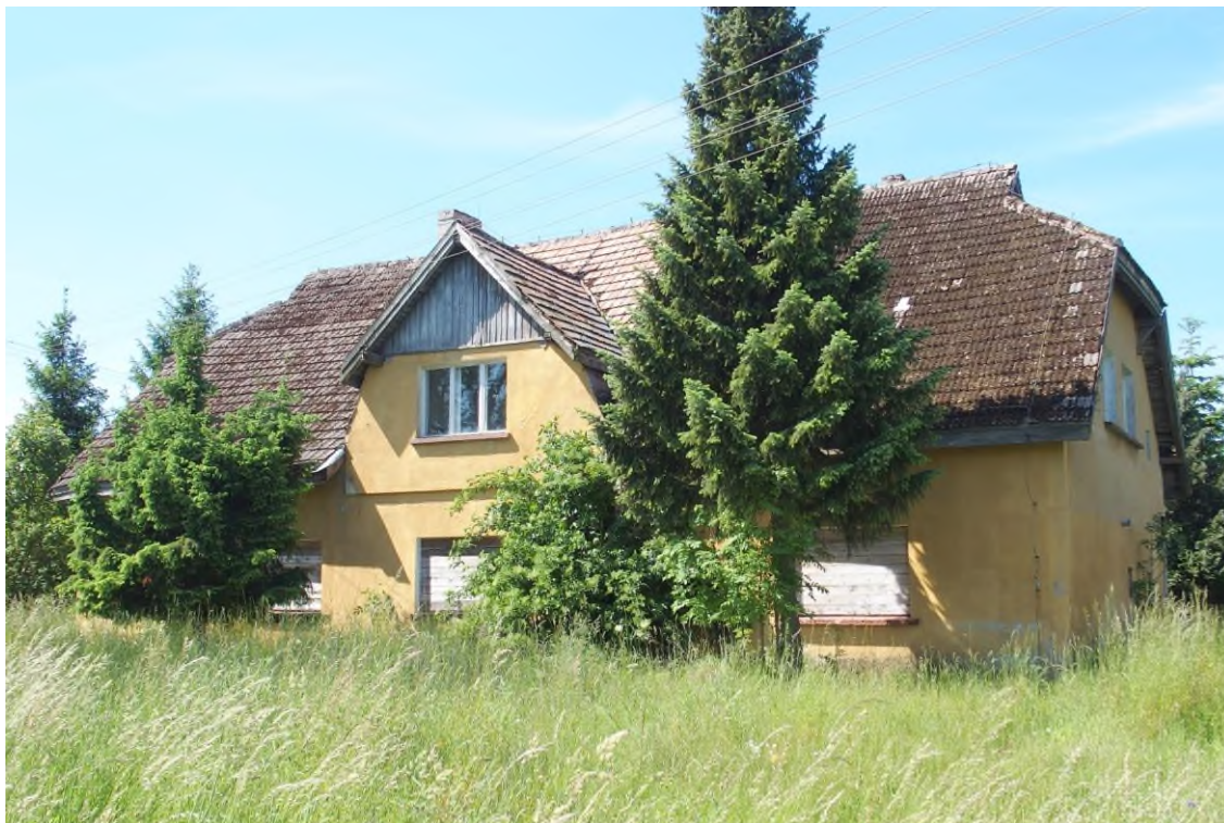
Widok budynku od północnego - wschodu
