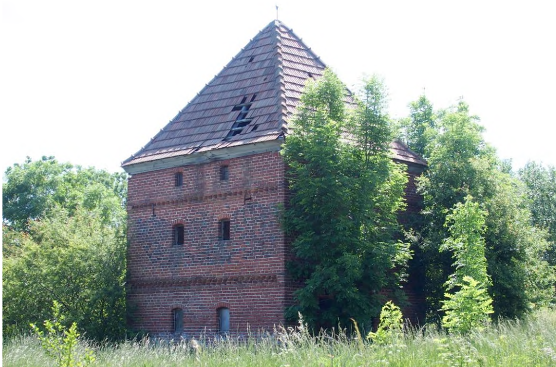
Widok budynku od północnego - zachodu
