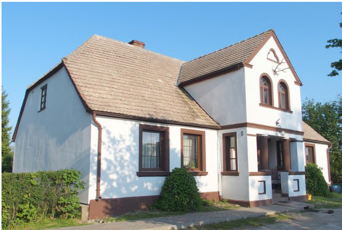
Widok budynku od północnego - zachodu
