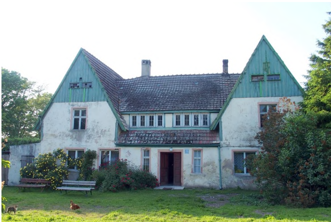
Widok budynku od południowego - wschodu
