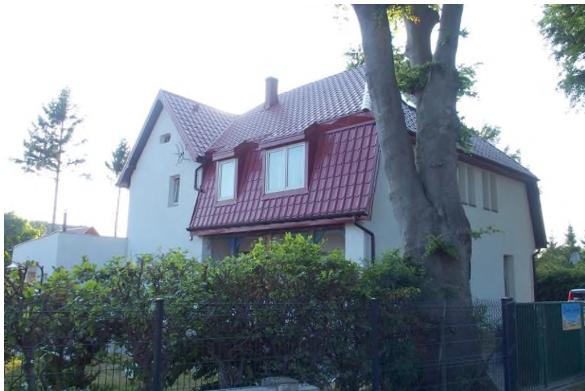
Widok budynku od południowego - wschodu
